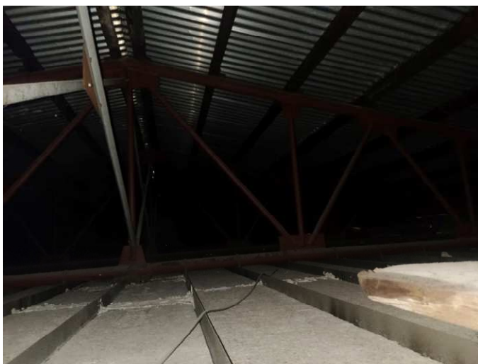
Pozn. stávající podhled v garážích (heraklitové desky + ocelové svařované T profily)
